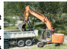
Décaissement (site Smigiba)
